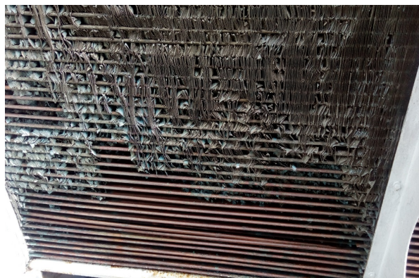
Коррозия теплообменников
