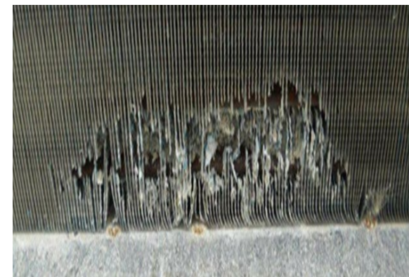
Коррозия теплообменников
