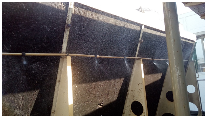
Засорение форсунок
